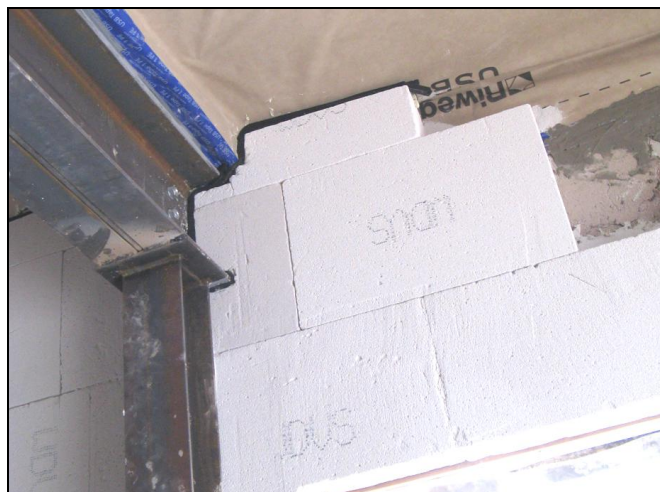
Dettagli, nastri espandenti e tenuta all'aria.
