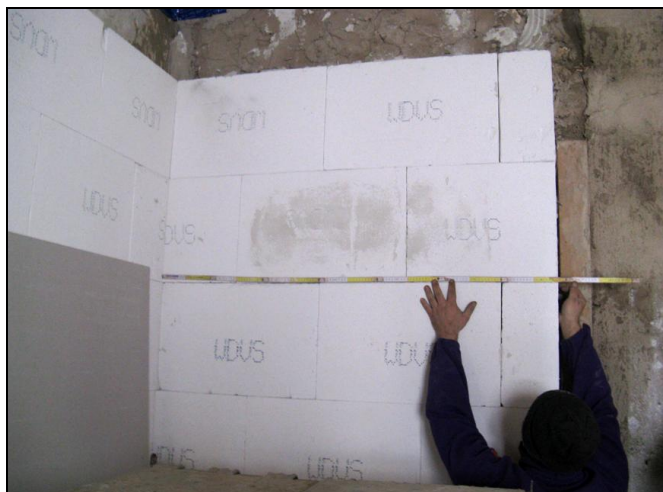
Correzione di ponti termici.
