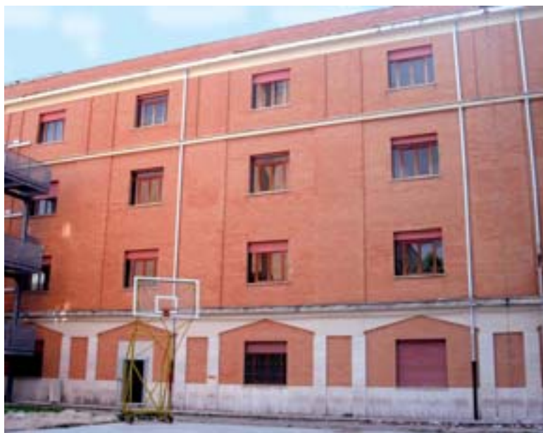
Fig. 1 - La scuola assunta come caso di studio (vista sud).
